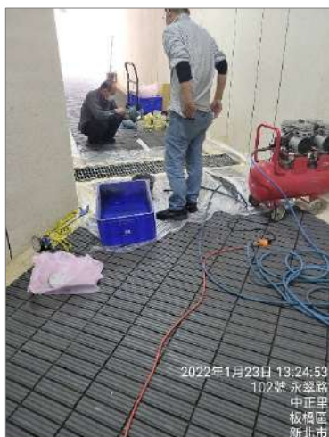
車道及水溝蓋止滑工程
