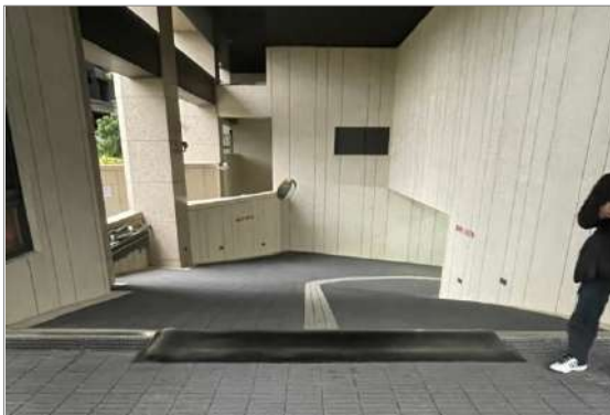
汽車道鋪設橡膠墊降低行經之噪音
