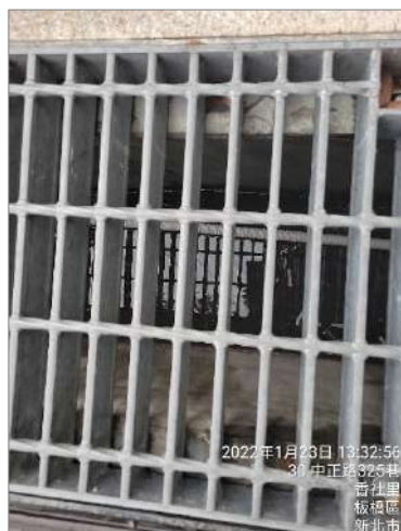
完成水溝蓋止滑
