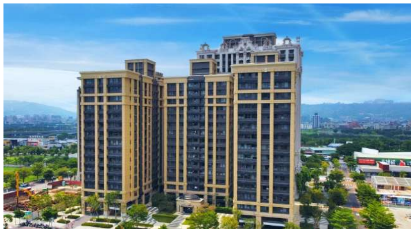
社區建築及外牆完整，無明顯損壞狀況
